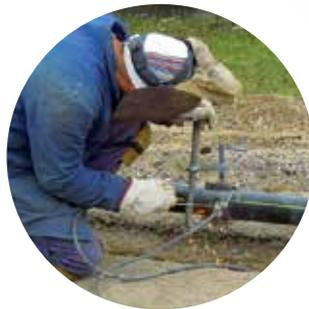
Cette fonction est conçue pour l'utilisation de l'électrode cellulosique, offre une stabilité d'arc exceptionnelle et une pénétration optimale. Elle est excellente pour le soudage dans toutes les positions.
